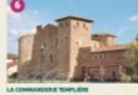
LA COMMANDERIE TEMPLIÈRE Construite en 1787, la Commanderie Templière est un véritable joyau de l'architecture militaire. Découvrez l'histoire de ce fort, à la fois historique et naturel.
